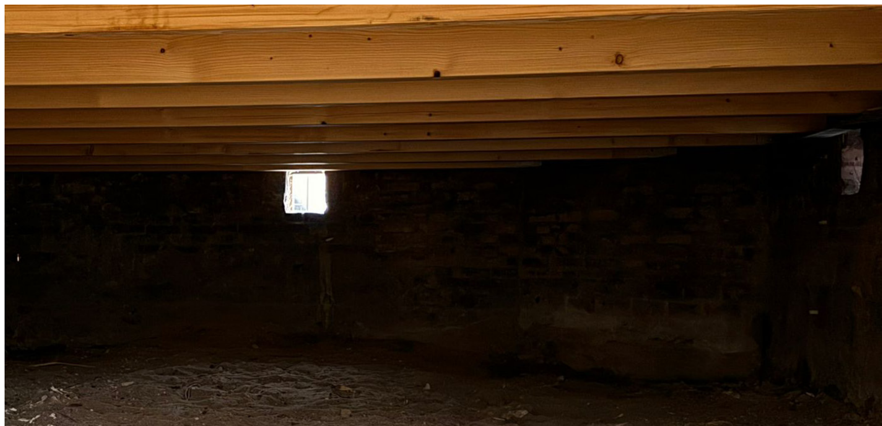
pos.3, sparing in voor- en zijgevel
