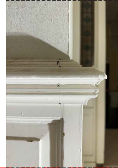
foto, detail bovenstuk profilering
