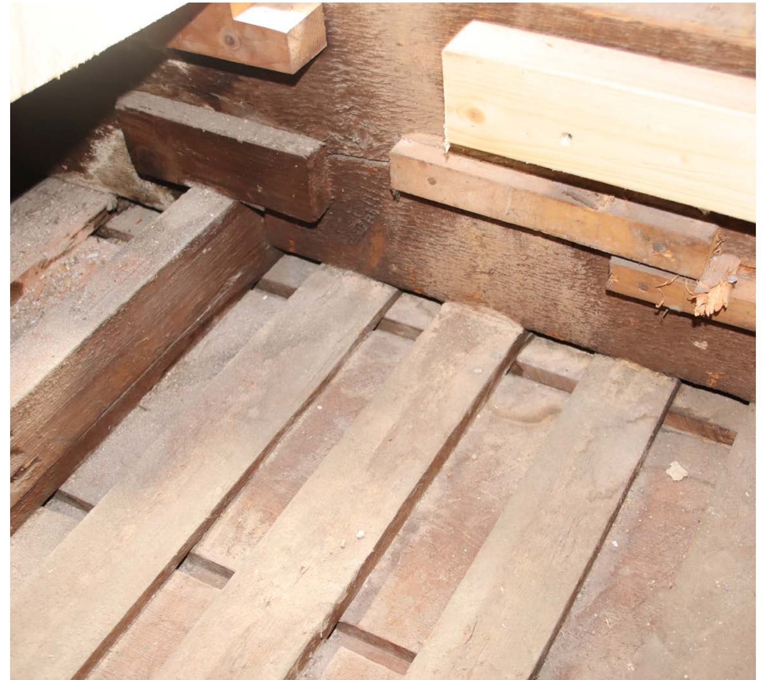
Opbouw plafond eetkamer op tengelwerk gezien vanuit de eerste verdieping
