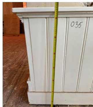
lambrisering type C: originele lambrisering restaureren
