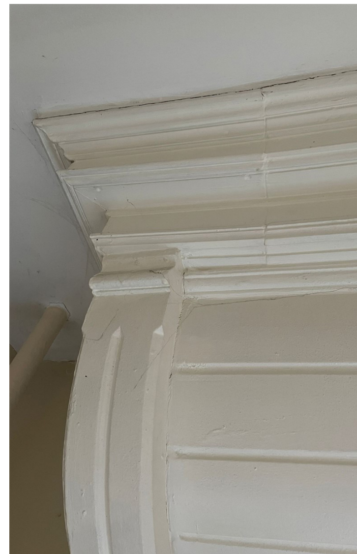
Detaillering bovenzijde met aansluiting op het plafond
