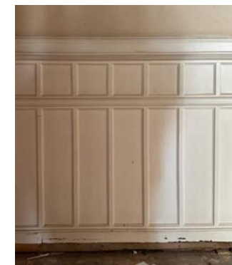
lambrisering type B: lambrisering conform huidige situatie (zonder additionele sierlijst aan bovenzijde)
