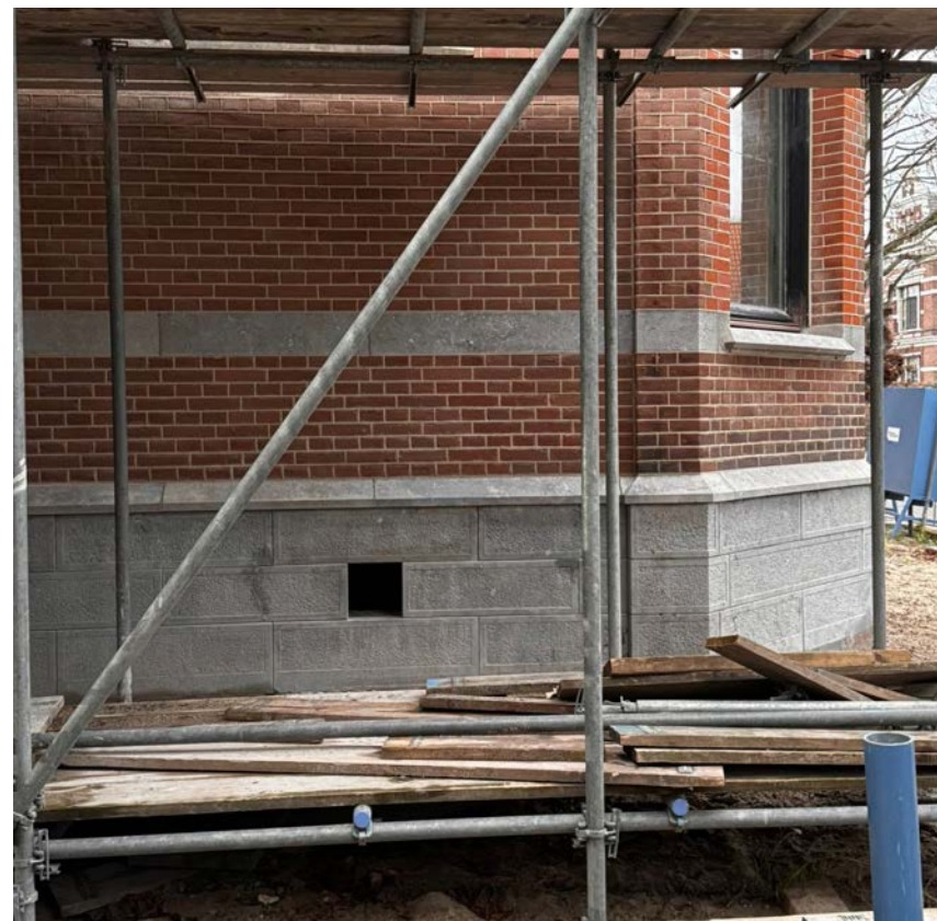
pos.2, sparing in linkerzijgevel, voor
