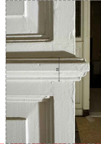
foto, detail middenstuk profilering
