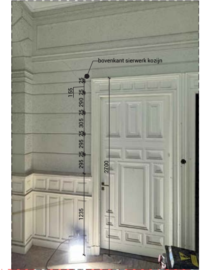
foto, lambrisering en maatvoering belijning wand
