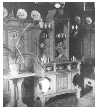
lambrisering type G: monumentale (lage) lambrisering restaureren en originele (hoge) lambrisering terugbrengen. namaken op basis van originele foto's.
