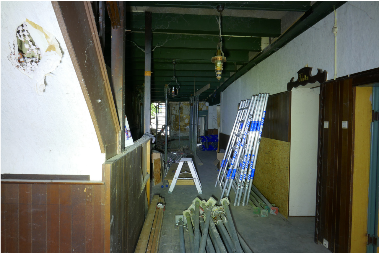
Afb. 4.52 Foto van ruimte 1.01, gezien met de rug naar de voorgevel. Deze ruimte was tijdens de laatste (orkest-)fase als foyer in gebruik.
