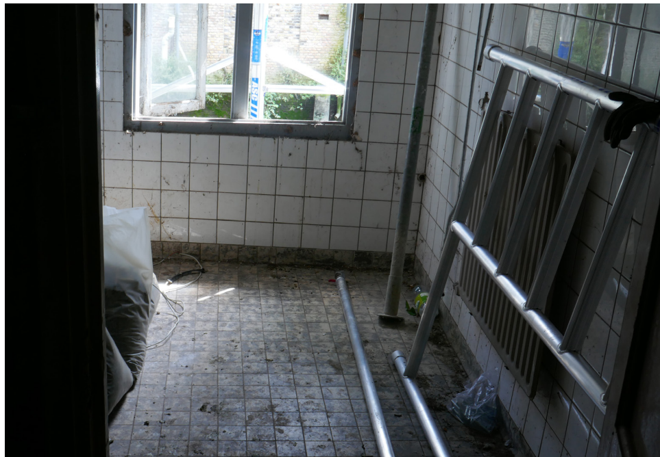
Afb. 4.25 Deze ruimtes rond 0.02b konden niet betreden worden, met het oog op de persoonlijke veiligheid. Delen van de achtergevel waren ingestort en de ruimte was gestut met behulp van metalen stempels.
