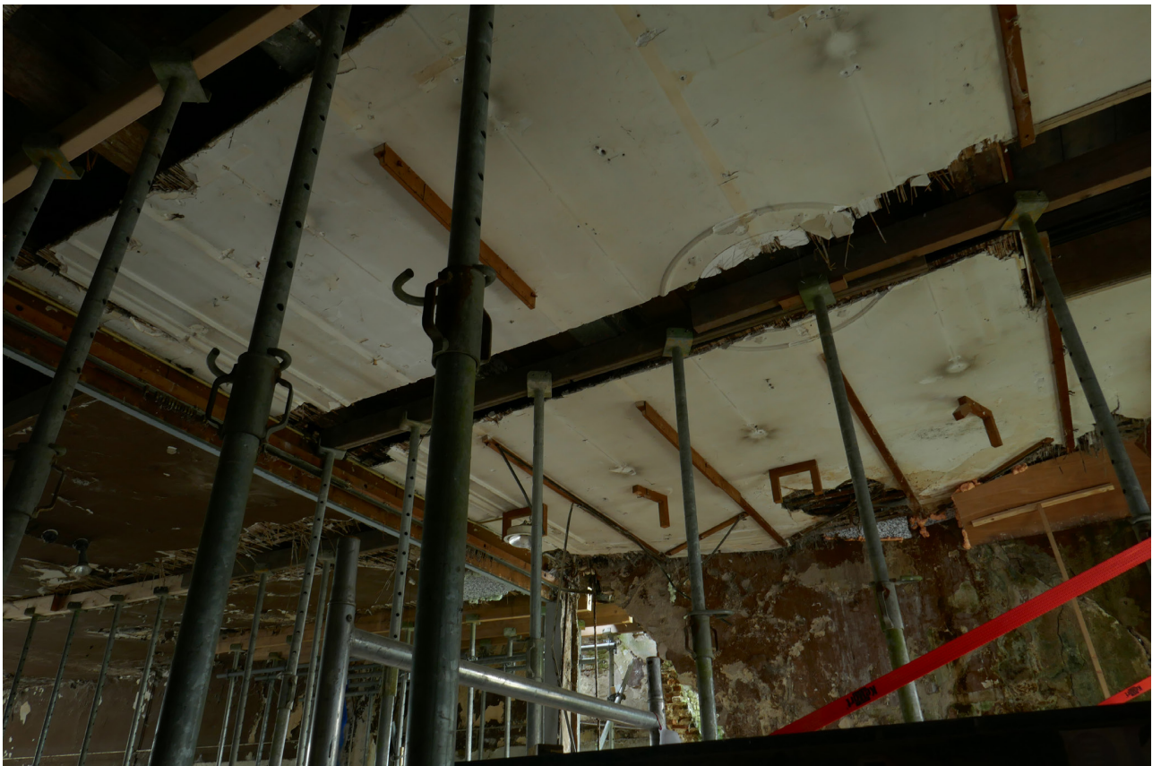
Afb. 4.91 Het plafond boven het toneel was voorzien van een gedecoreerd (doch beschadigd) stuc-op-rietplafond.
