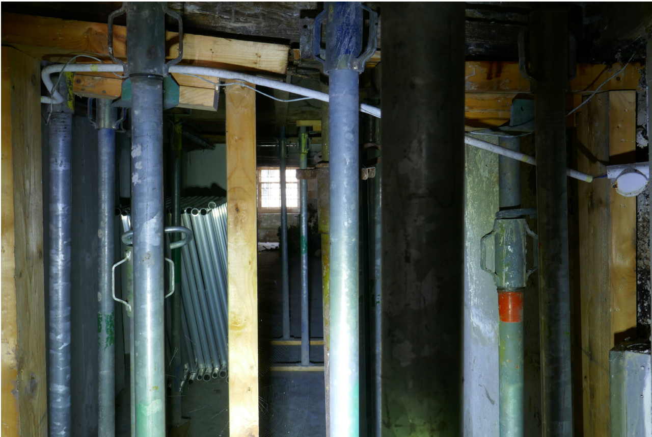
Afb. 4.21 Foto van ruimte 0.02, gezien richting de voorgevel. Duidelijk zichtbaar is het woud aan metalen stangen van de steunconstructie die hier werd aangebracht. Dit verhinderde het onderzoek iets.
