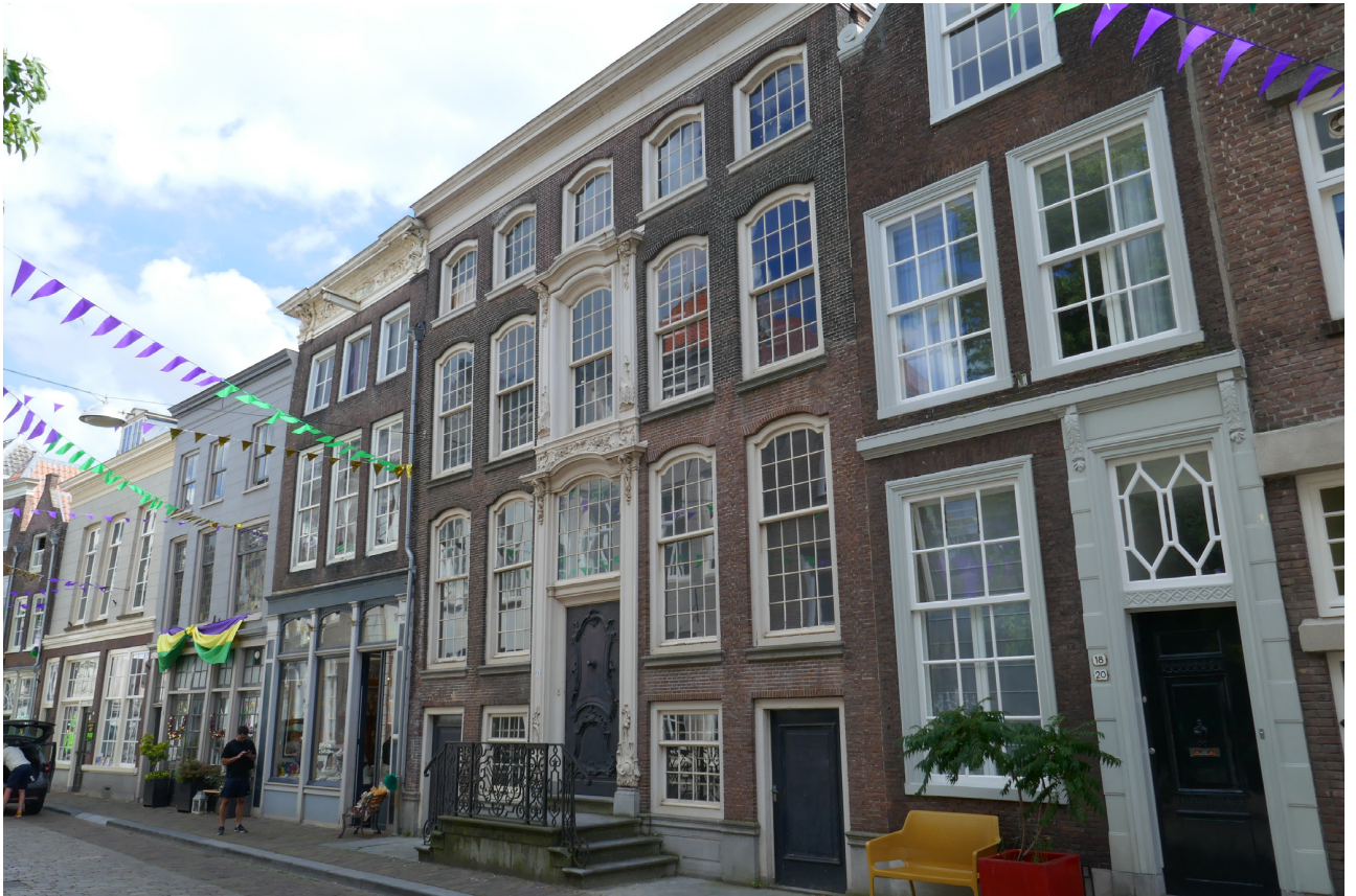
noord- of voorgevel
