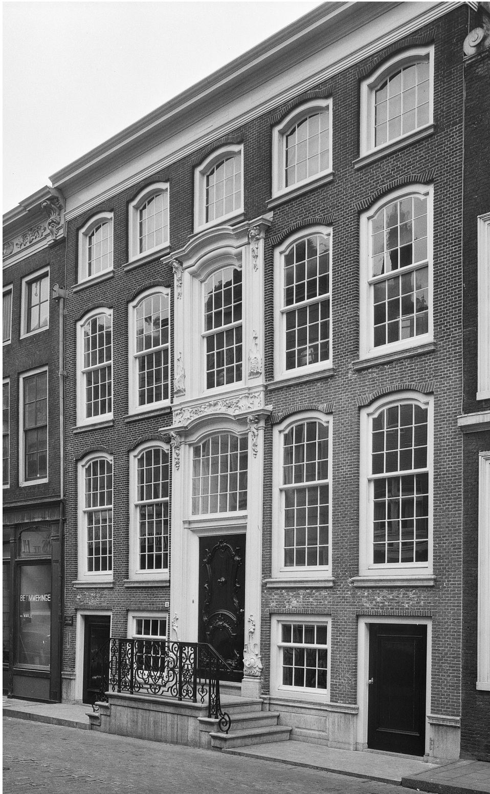
Afb. 3.16 Foto van de voorgevel na de restauratie rond 1954. De situatie is goed vergelijkbaar met de vóór-foto op afb. 3.15, en de wijzigingen zijn duidelijk waarneembaar (zie ook lopende tekst). RCE invnr 058739
