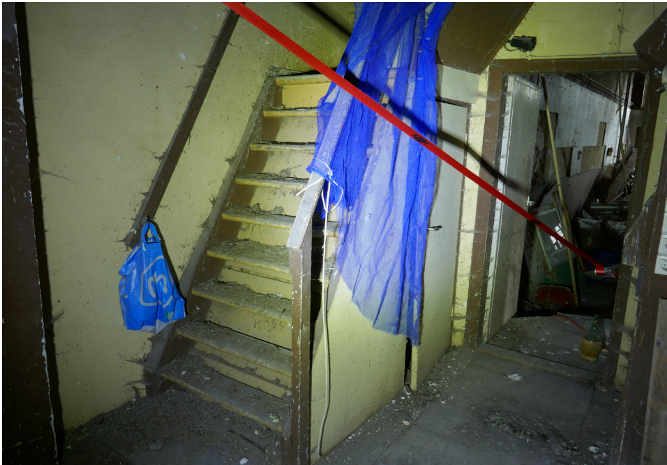
Afb. 4.90 Foto van de trap aan de westzijde van het toneel (genomen met de rug naar de achtergevel). De trap leek relatief recent te zijn ingebracht, ter vervanging van een ouder exemplaar. De diverse afwerkingen zijn goed zichtbaar.
