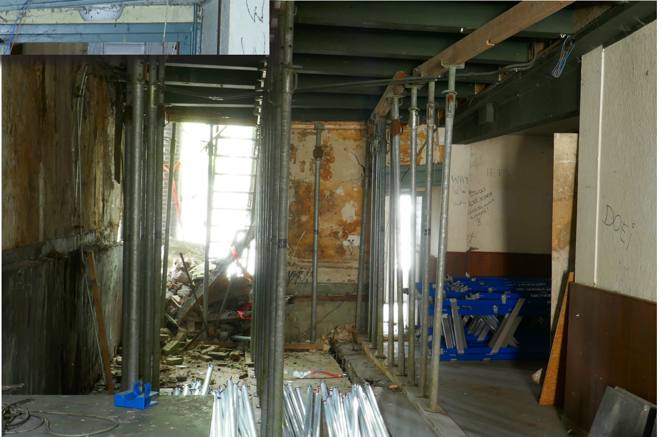
Afb. 4.56 Foto van 1.01, gezien richting de achtergevel. De schade in dit gedeelte is duidelijk zichtbaar, met het geheel ingestorte deel links. Let ook op de steunconstructie d.m.v. stempels. Inzet: de doorgang naar 1.02 was zeer sterk verzakt (vergelijk met 4.57).
