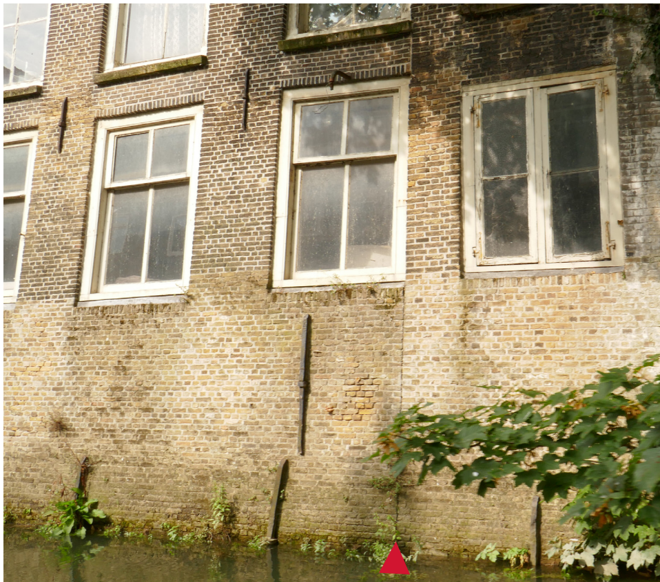
Afb. 4.12 Foto van de onderzijde van de achtergevel, waar zich rechts naast de derde vensters (onderhuis en 1e verdieping) een grote, verticale bouwnaad bevond (zie rode pijl).
