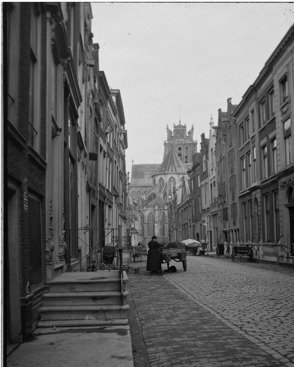
Afb. 3.8 Foto van de gevel na de verbouwing in 1882 (geheel links vooraan).
