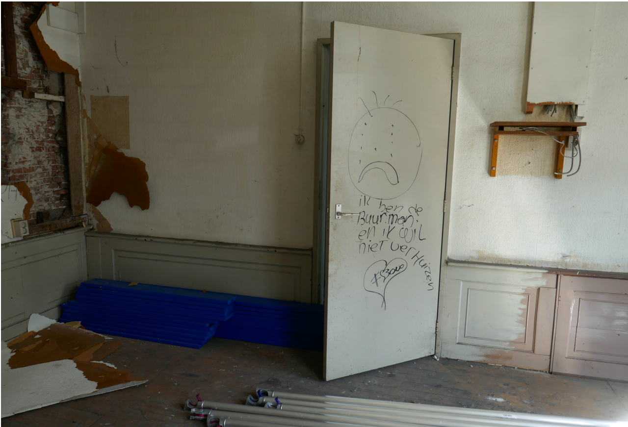
Afb. 4.65 Foto van de oostwand van 1.03. Deze is niet oorspronkelijk maar werd hier later (tenminste na 1955) geplaatst. De lambrisering (zo'n 67 cm hoog) lijkt hergebruikt en sluit links (en rechts; zie 4.63) niet goed op de andere lambriseringen aan.
