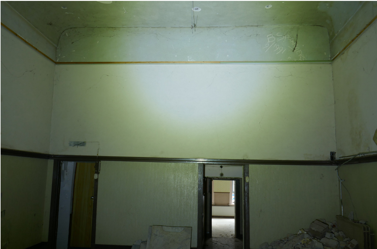
Afb. 4.39 Foto van ruimte 0.05, gezien richting de achtergevel. De hoogte van de ruimte is goed zichtbaar, en de plafondhoogte is in feite die van de bel-etage.
