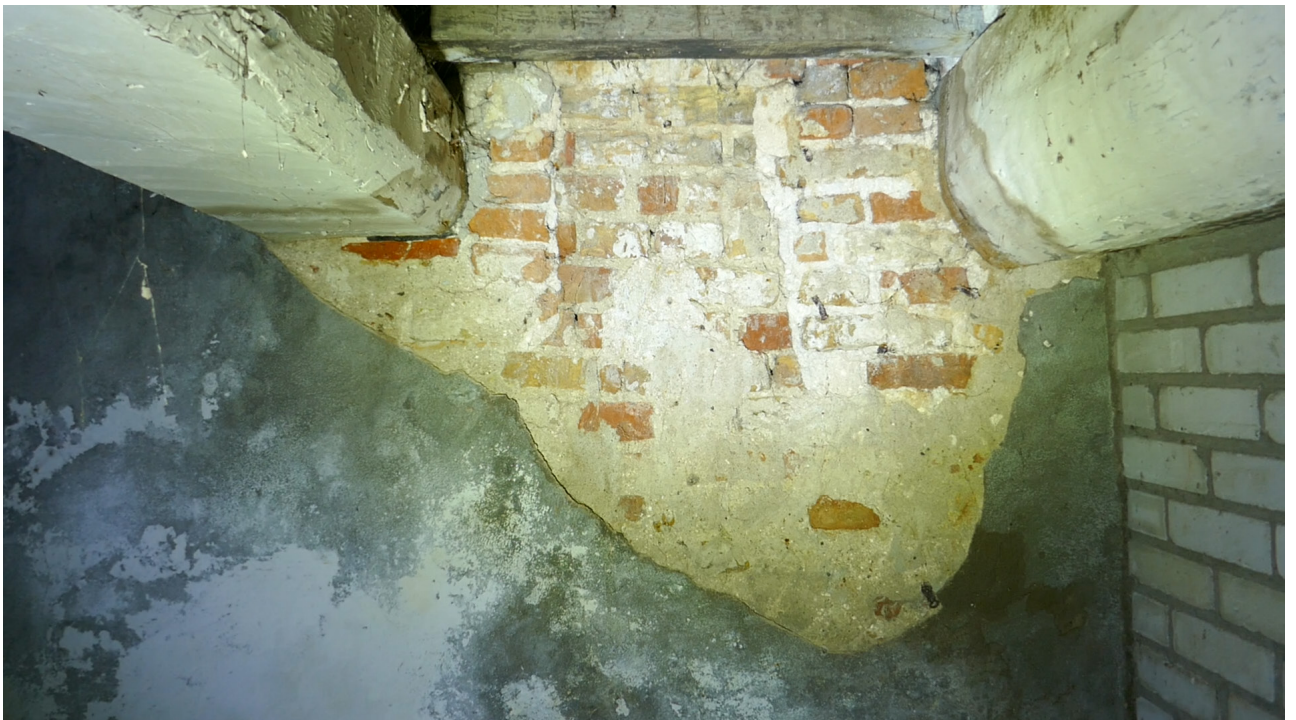
Afb. 4.19 Ook bij de oostwand waren enkele delen metselwerk te zien (hoewel minder dan bij de westwand). Hier lijkt een dichtgezet (balk-?)gat zichtbaar te zijn.
