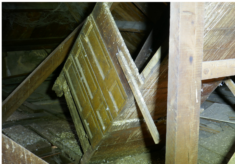
Afb. 4.97 Ook bij de eerste koker (zie ook 4.94) waren oude vensterluiken hergebruikt. Hun herkomst en datering was niet exact vast te stellen.
