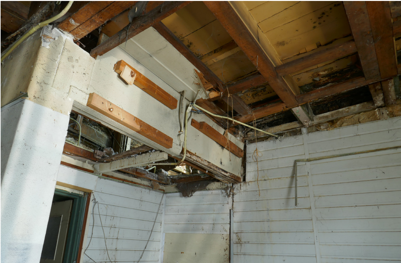
Afb. 4.61 Foto van het plafond van 1.02. Een plafond van plaatmateriaal was hier recentelijk verwijderd (of was naar beneden gekomen). Daarboven was een oudere, geel geverfde balklaag zichtbaar. Deze was strak en uniform van maat en vormgeving.
