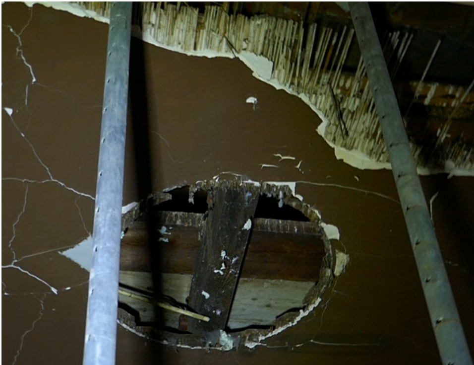
Afb. 4.86 In het plafond van zaal 2.01 waren drie ronde openingen aanwezig, waar metalen roosters in leken te hebben gezeten (zie 4.87). Dit plafond werd in 1882 op een verhoogde positie aangebracht, en bevat dus geen oudere materie.
