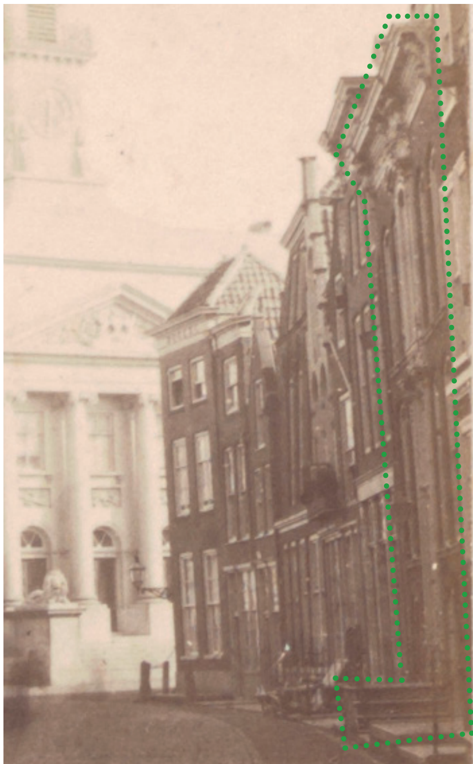
Afb. 3.5 Detail van een stereofoto uit circa 1860-'70, waarop de voorgevel van nr. 16 te zien valt (met groene stippellijn aangegeven), zij het zeer schuin. Ondanks de schuinte, valt toch goed te zien dat de gevel in de periode een stuk lager was; een gehele rij vensters bovenaan was nog niet aanwezig. RAD 552_319755
