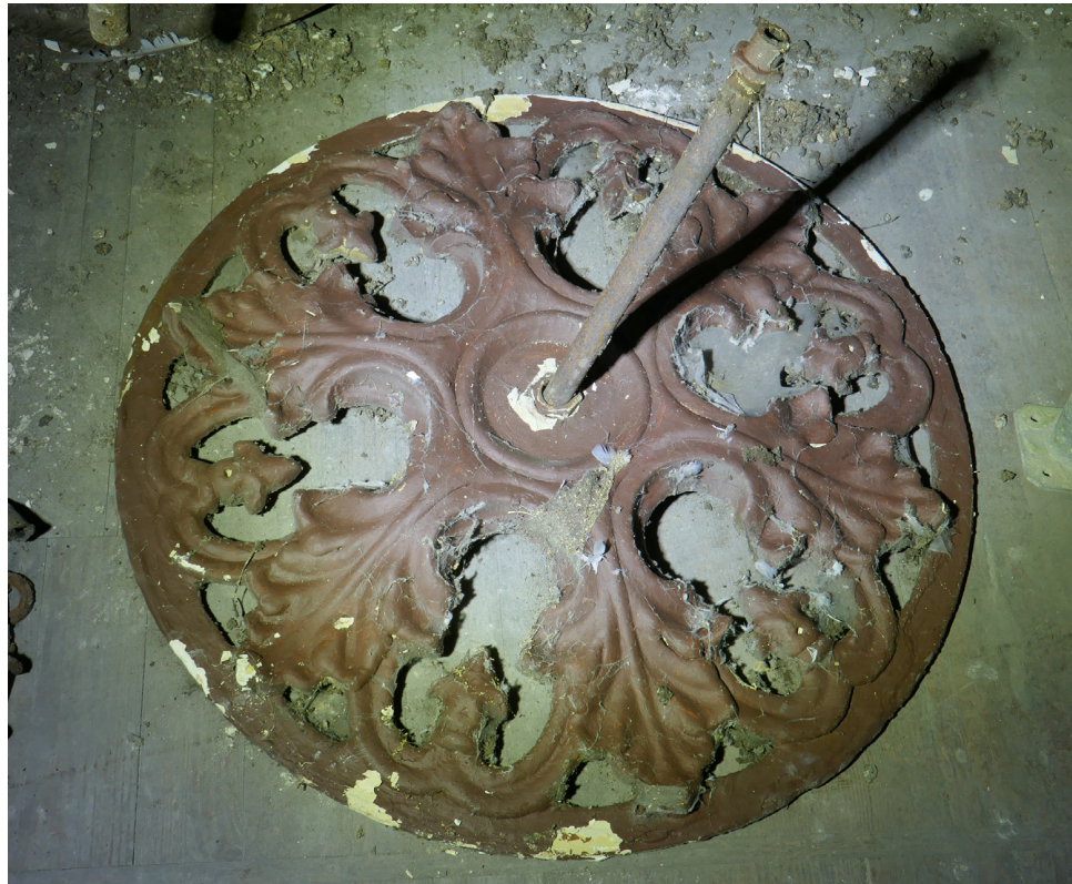
Afb. 4.87 Tegen de oostwand van 2.01 lagen drie metalen roosters, die rijk gedecoreerd waren. Centraal is een buis voor een gasverlichting aanwezig. De roosters stammen zeer waarschijnlijk uit 1882.
