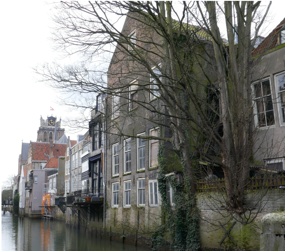
Afb. 4.8 Foto van de achtergevel van het pand, gezien vanaf de Lombardbrug. De foto werd aan het einde van de winter genomen, waardoor de boom nog niet in het blad stond en het zicht op de gevel nog enigszins vrij was. De grote achtergevel strekte zich niet over de volle breedte van het perceel uit: rechts ervan (vooraan op de foto) kende het pand een smalle strook met lagere bebouwing (zie ook afb. 3.12).
