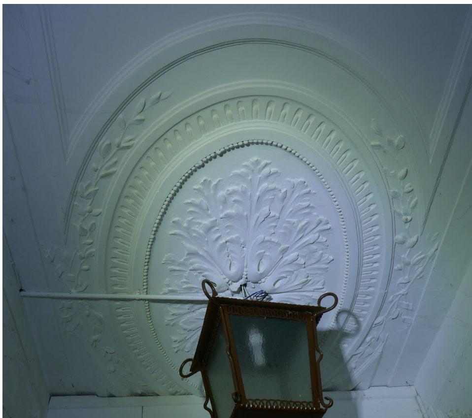
Afb. 4.47 Tegen het plafond van de entreehal 1.05a bevond zich een ovaal stucplafond. De stijl en uitvoering van dit element deden een latere datum vermoeden dan die van de stucdecoraties op de zijwanden.
