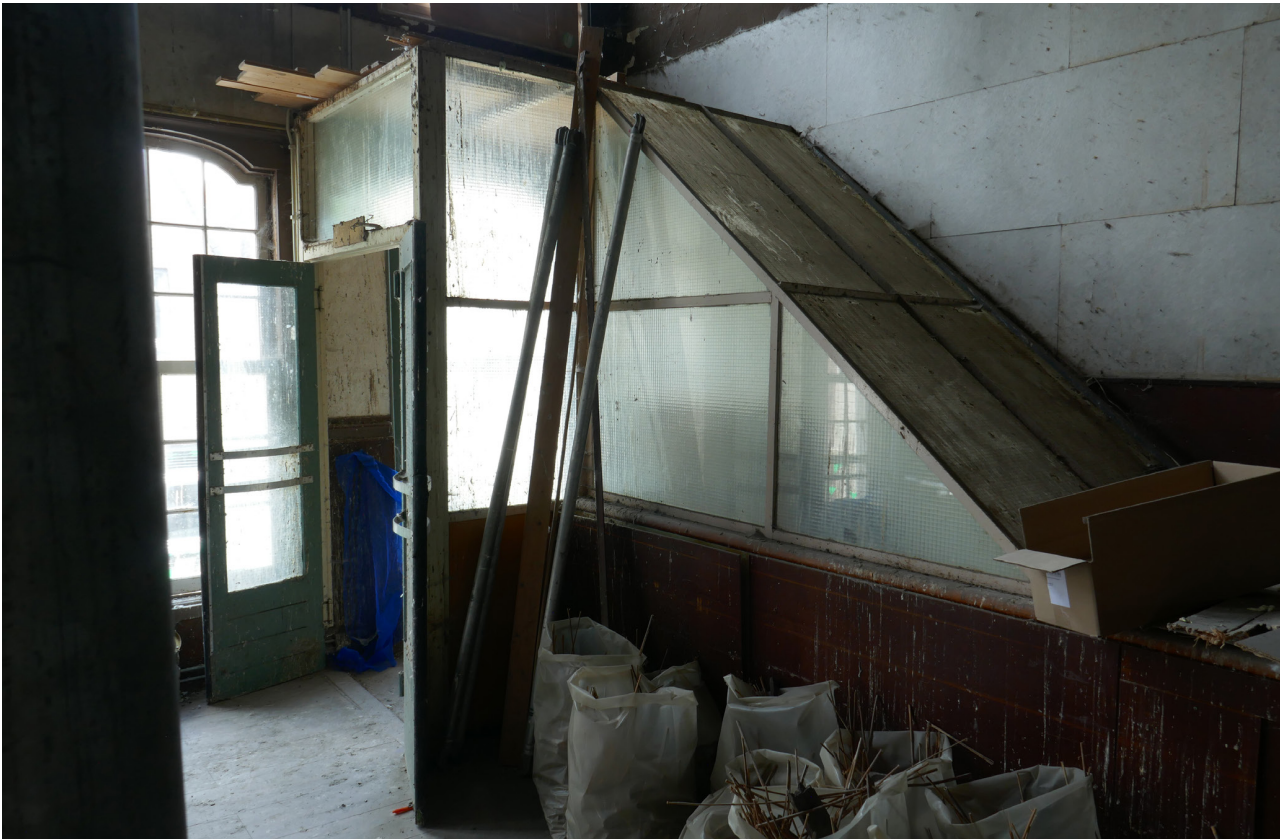
Afb. 4.82 Foto van het trappenhuis 2.01a, dat vanuit de bel-etage naar de toneelzaal op de 2e verdieping voerde (links is de voorgevel, met venster, zichtbaar). Het trappenhuis had een ombouw van veiligheidsglas die in 1955 (ter geluidsisolatie) was ingebouwd.
