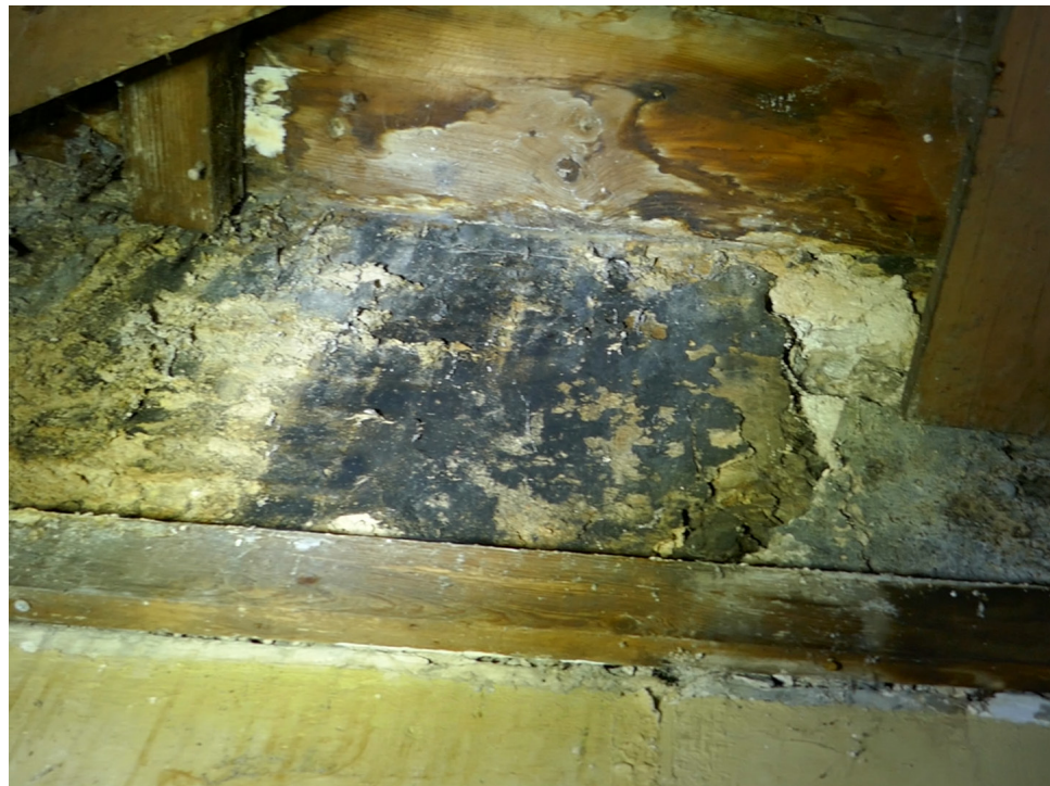
Afb. 4.78 Foto van de strook boven de bepleistering van de westwand van 1.04. Hier was middenin de afdruk van een voormalig rookkanaal te zien, dat hier niet onlogisch was gepositioneerd (zie ook 4.79).
