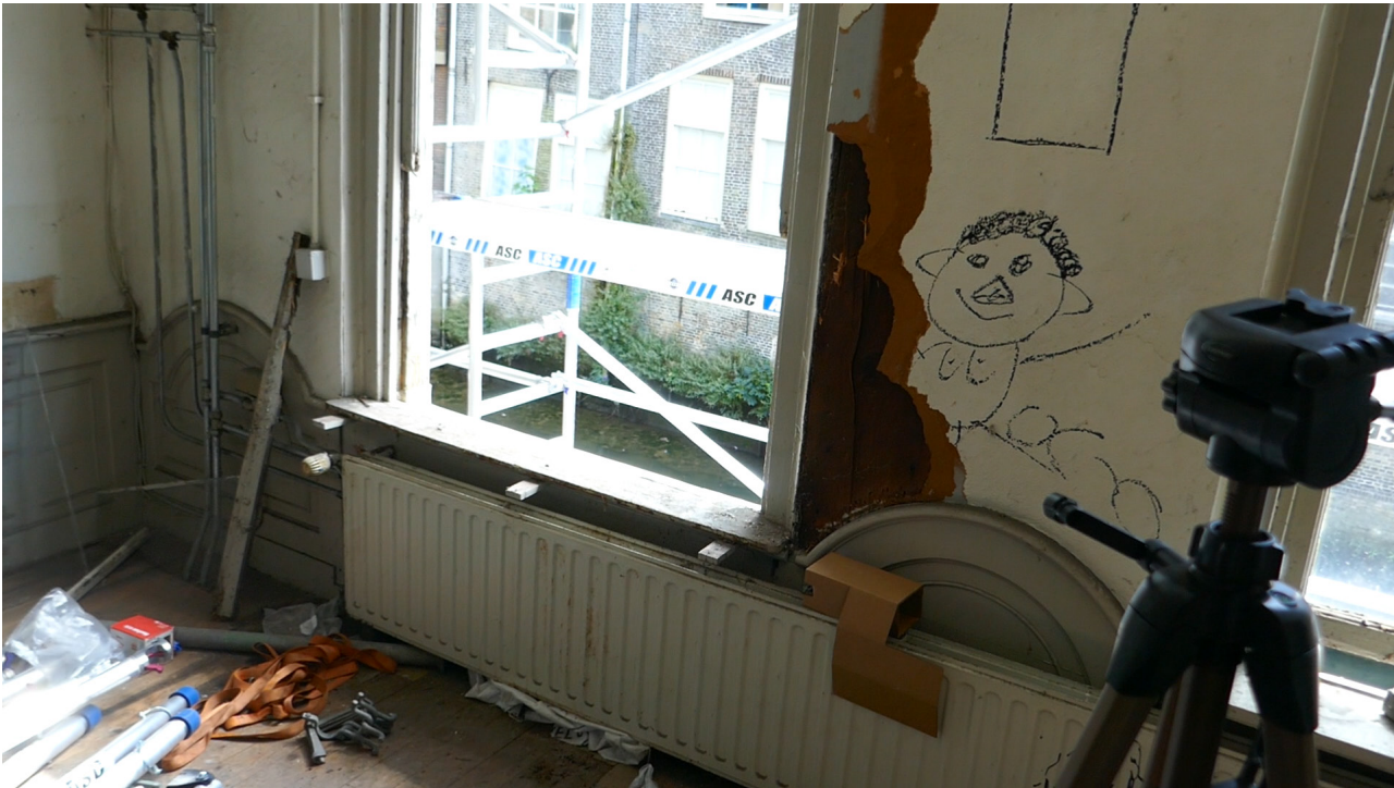
Afb. 4.63 Foto van de achtergevel van 1.03, waar een lambrisering aanwezig was die bij de muurdammen opvallend halfronde uitspringingen bezat. Zijn leeftijd werd niet geheel duidelijk.
