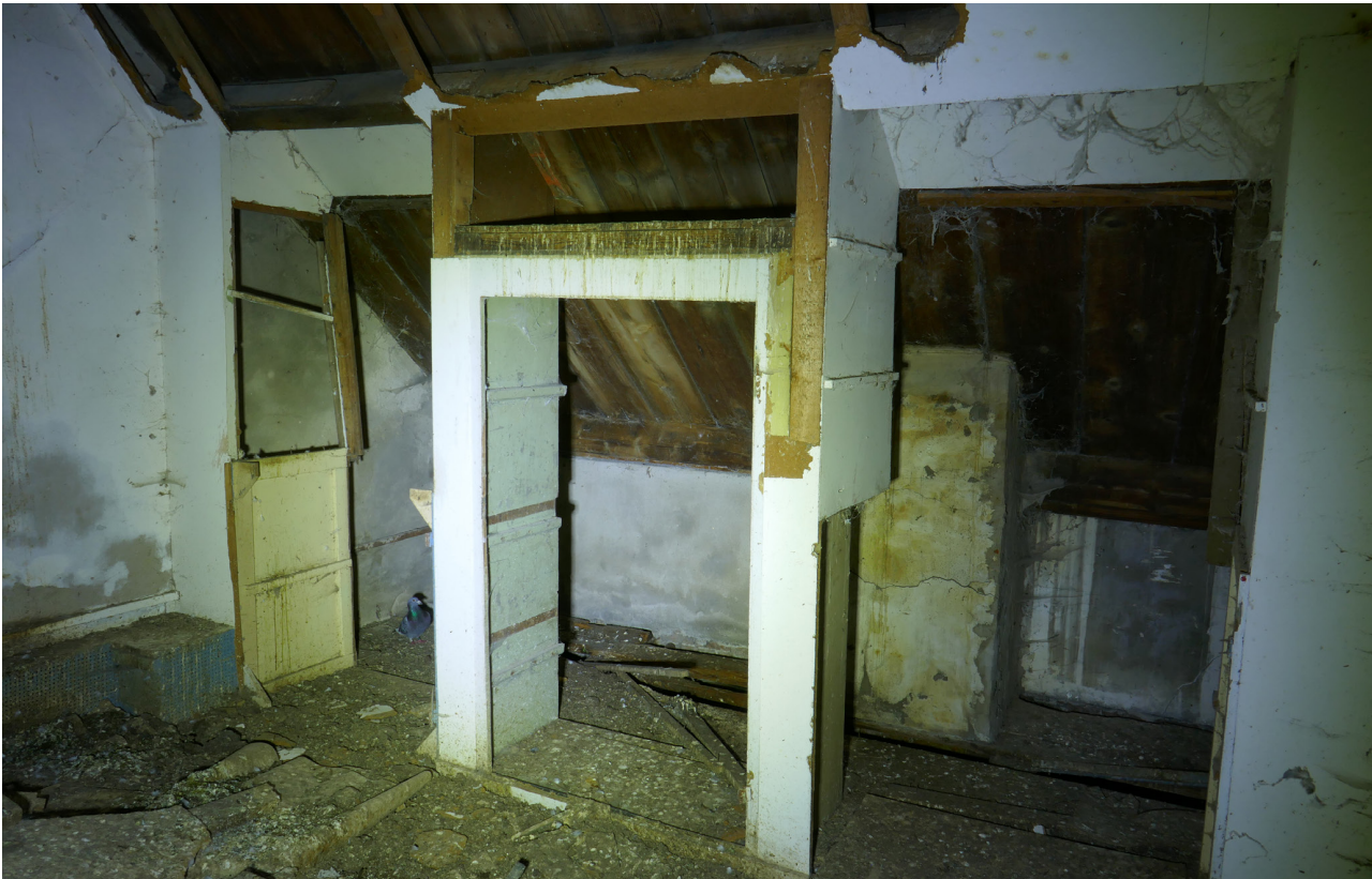
Afb. 4.104 Foto van de westelijke zijde van zolder 3.03. Hier waren (provisoirisch) enkele hokken ingebouwd die niet verder bestudeerd konden worden. Wel zijn de verschillende gebruikte materialen zichtbaar.
