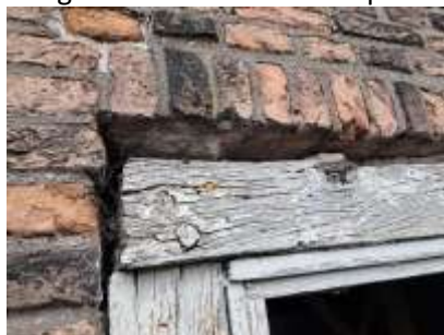
Aangetaste delen bovendorpels door slecht schilderwerk en inwatering.
