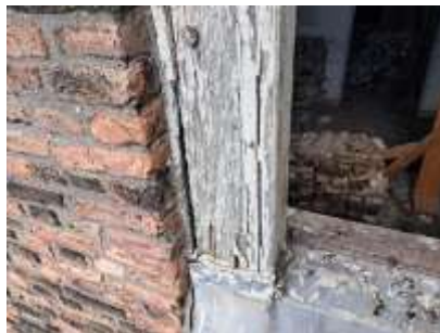
Aangetaste delen bovendorpels door slecht schilderwerk en inwatering.
