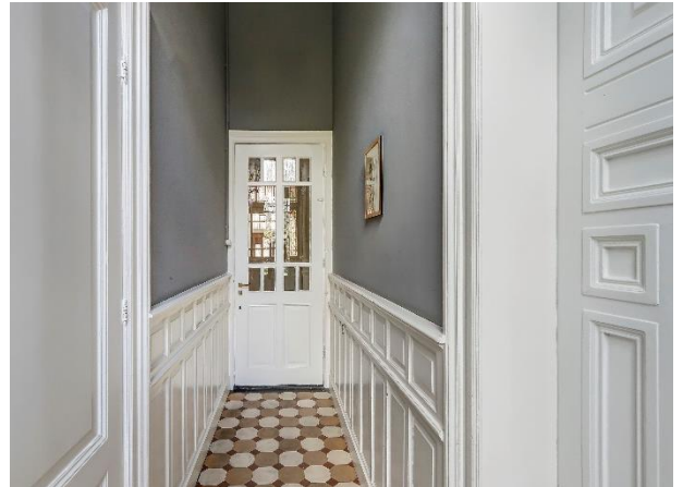
foto 30. Overzichtsfoto keukengang richting tussendeur naar vestibule, ruimte 0.2, 2021, Zoomers Makelaardij
