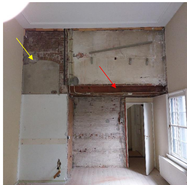
foto 32. Wand werkkamer richting trappenhuis na demontage interieur afwerking. Een gemetselde wand met boogje (geel) en een originele stalen ligger (rood) komen tevoorschijn, ruimte 0.4, juni 2022, [REDACTED]
