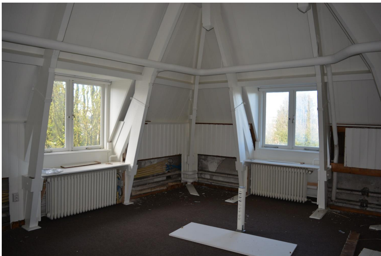
foto 53. Ruimte 2.4 (slaapkamer) met kruipluik naar kapje boven grote erker zijgevel. De spantconstructie in deze ruimte is goed zichtbaar, het dak bestaat uit een samengestelde spantconstructie, april 2022
