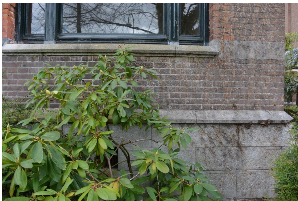
foto 3. Natuurstenen plint en waterlijst (voorgevel), april 2022
