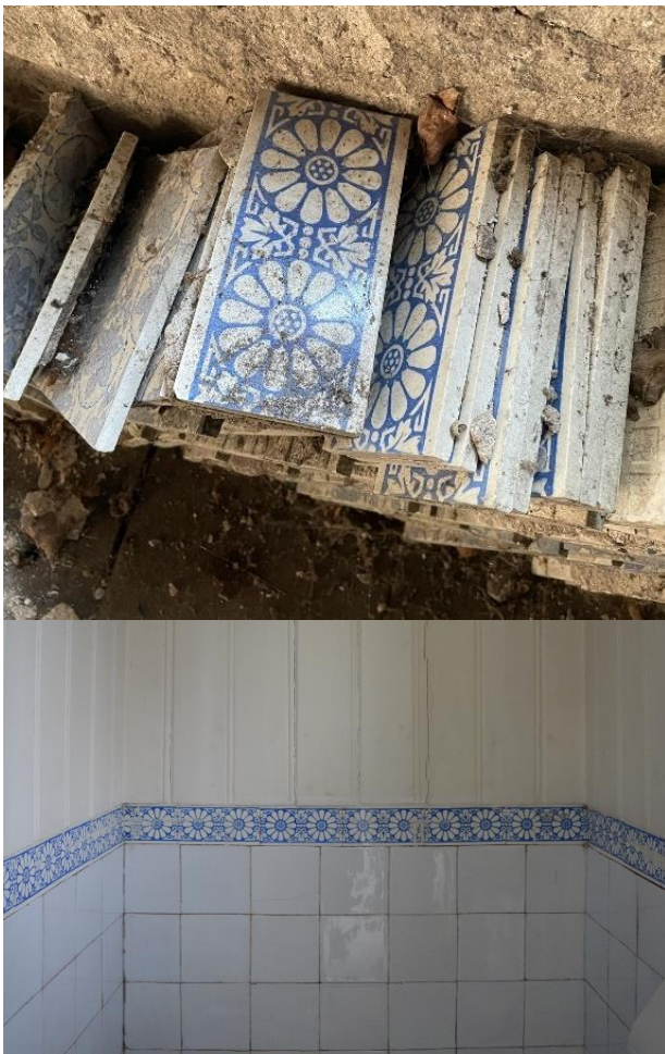
foto 39. Originele tegellambrisering en houten wandbekleding en reserve tegels (in opslag) voor toilet in aanbouw, ruimte 0.8, april 2022
