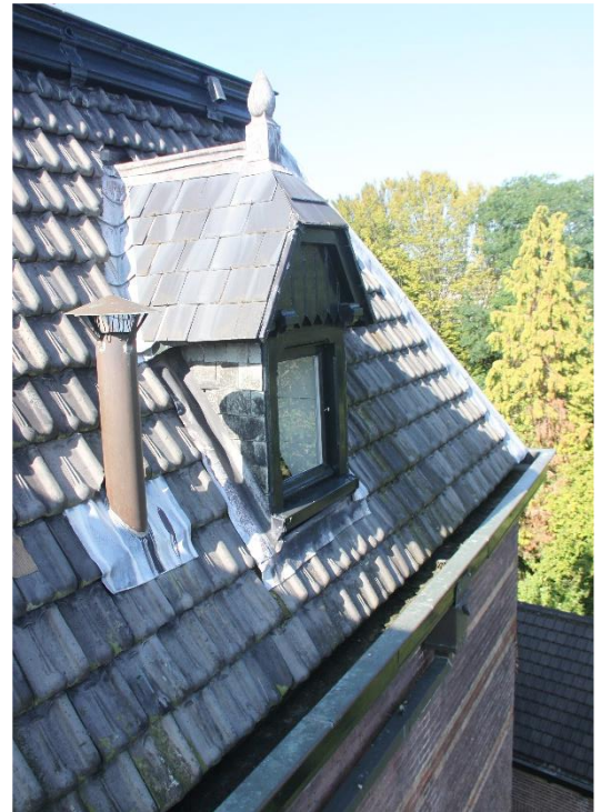
foto 20. Origineel dakkapel inclusief dakbedekking op zijdakvlak, 20 21, [REDACTED]
