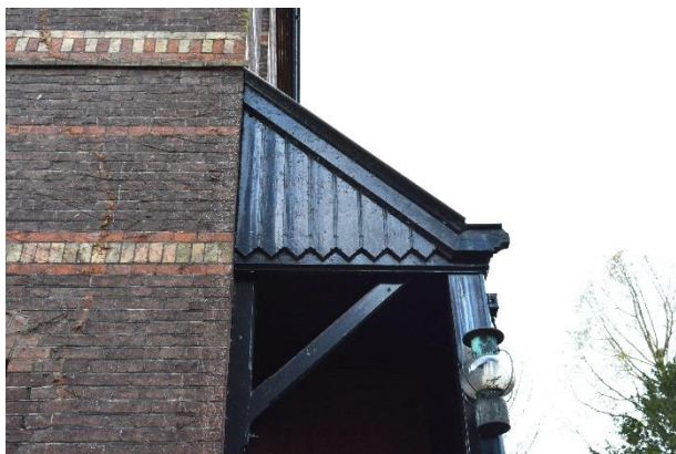
foto 16. Houten aftimmering uitbouw aan achtergevel met een stuk metselwerk van de rechterzijgevel, april 2022
