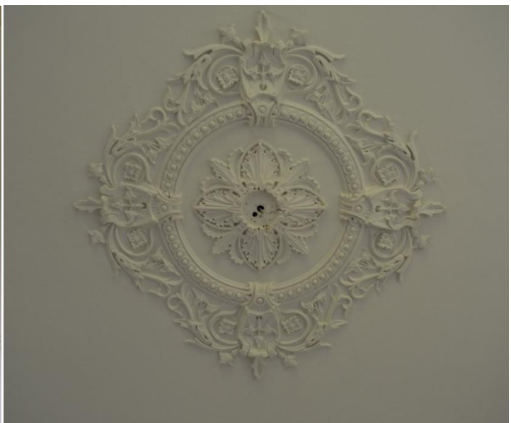
foto 45. Vermoedelijk originele plafondrozet in ruimte 1.4, april 2022
