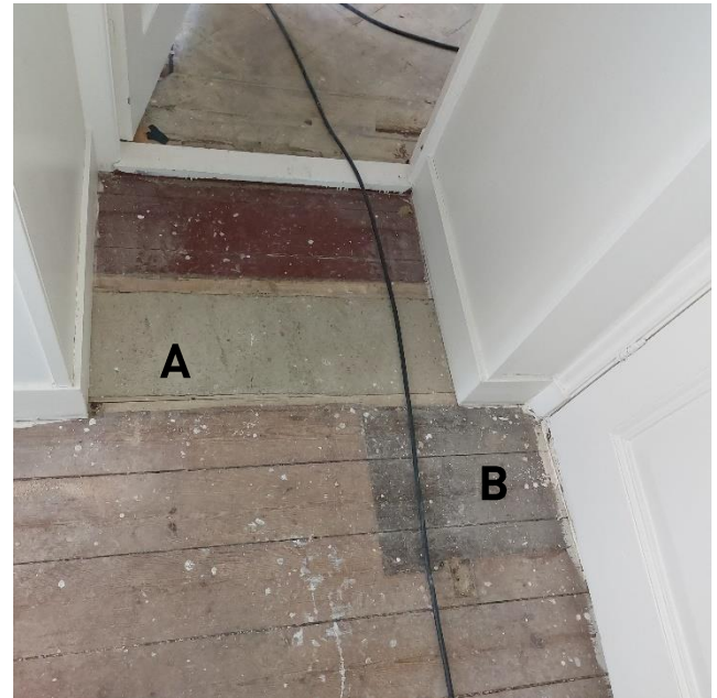
foto 44. Bouwsporen na demontage vloerbedekking tussen zitkamer (1.1) en boudoir, ruimte 1.2, 2022, P. [REDACTED]
