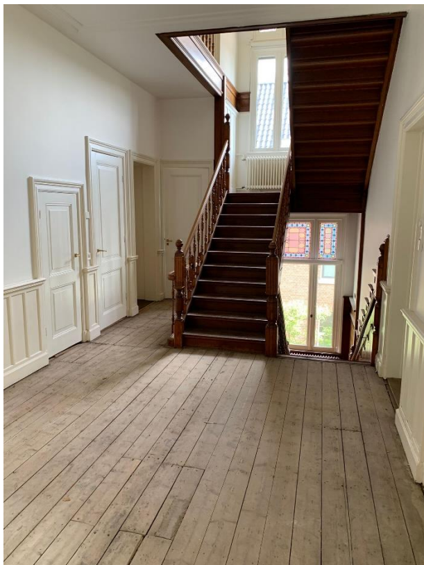
foto 63. Ontmanteling vloerbedekkingen verdieping, juni 2022.
