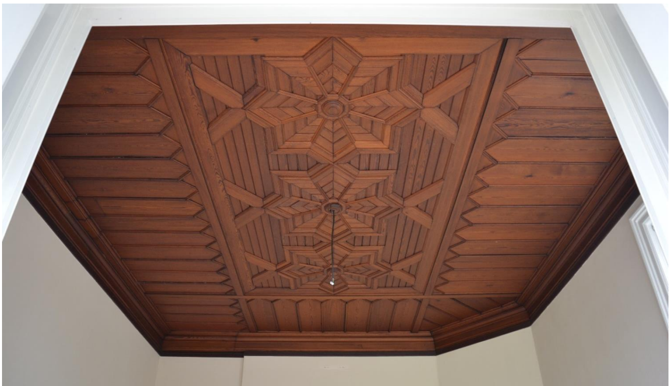
foto 36. Houten (casette)plafond met stervormige motieven, ruimte 0.6, april 2022
