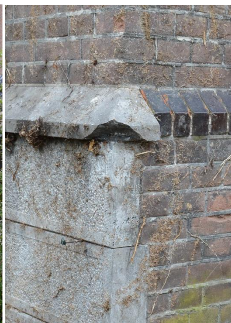
foto 2. Natuursteen detail (hoek voor en zijgevel), aan de zijgevel loopt de waterlijst verder in baksteen, april 2022
