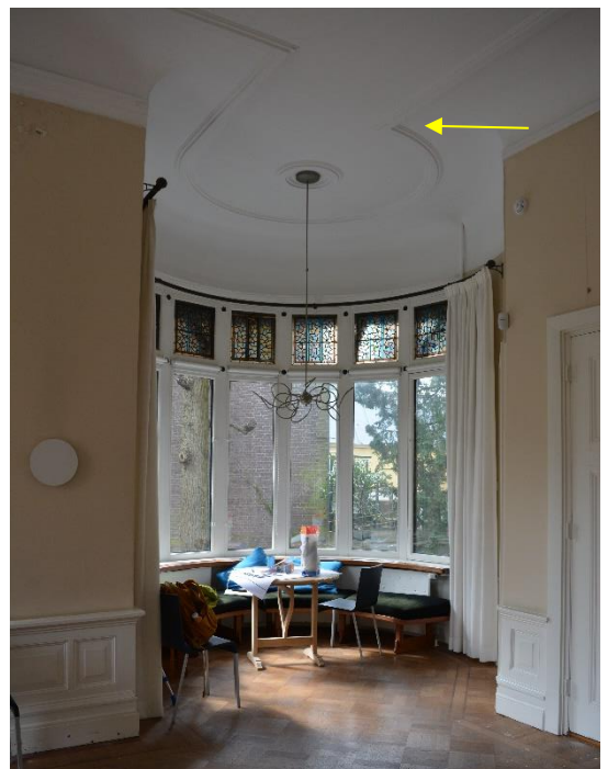
foto 34. Overzichtsfoto binnenzijde 'tuinkamer' of grote erker. De gestucte plafondlijst loopt door vanuit de grote kamer, ruimte 0.5, april 2022
