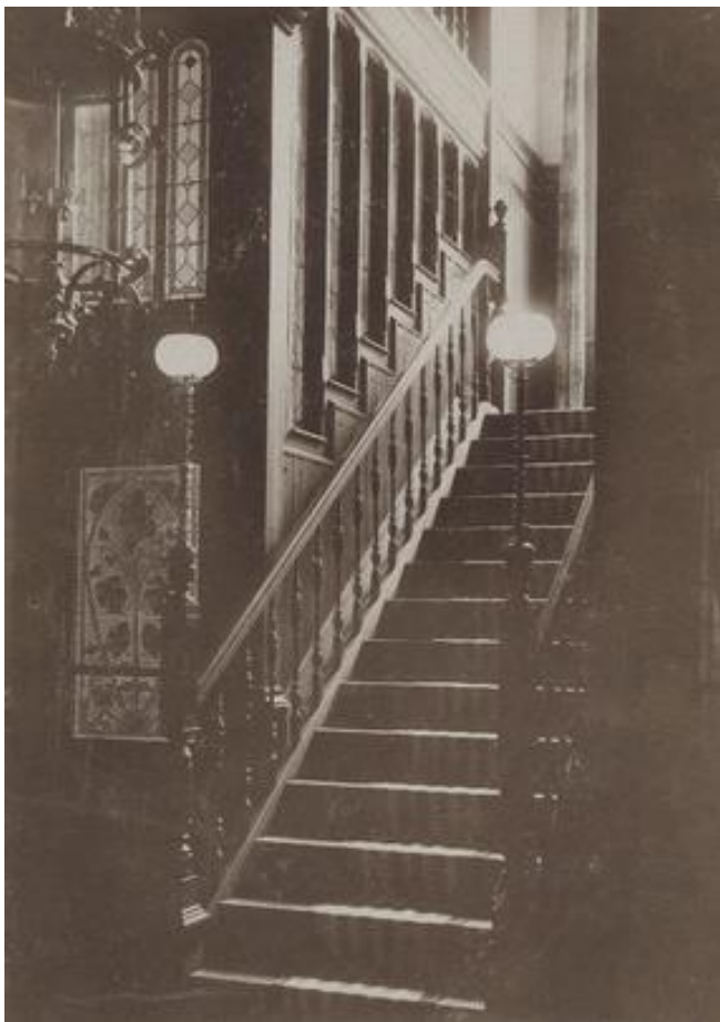
afb. 36. W. Kromhout, Trappenhuis na oplevering met twee lantaarns op de balusters, 1895, bron: HNI KROM 15 4
