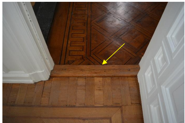
foto 38. Drempel tussen kamer en vestibule (detail afgebroken parketvloer vestibule), ruimte 0.6, april 2022
