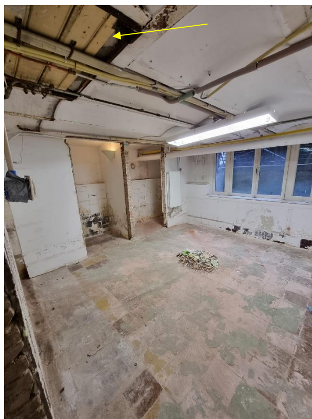
foto 56. Ruimte -1.3 voormalige was- en mangelkamer. In het plafond wat bestaat uit troggewelven is een raveling (sparing) voor de liftschacht waarmee (vuile) was en voedsel verplaatst kon worden, juni 2022, [REDACTED]
