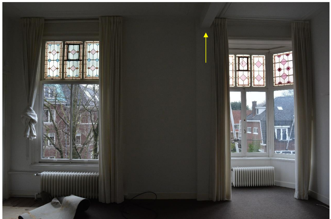
foto 43. Voormalig boudoir en logeerkamer met gezicht op voorgevel, bij de pijl de ondervanging van de gesloopte scheidingswand, ruimte 1.2, april 2022
