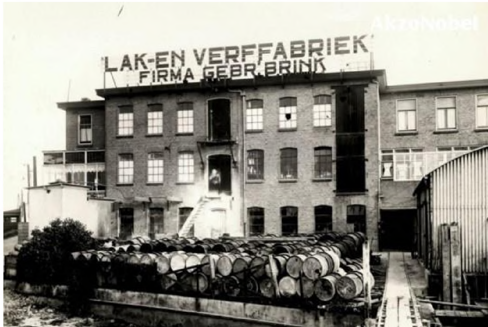
Figuur B1.1 Foto's van voor jaren 60 (bron AkzoNobel). Dit betreft het gebouw aan de lek direct naast de huidige veerpont welke niet meer in handen is van Akzo. Het gebouw is inmiddels meermalen gerenoveerd
