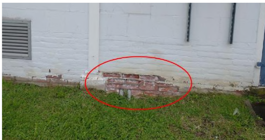
Figuur 5.3 Verwerking op de buitenmuren van gebouw 39
