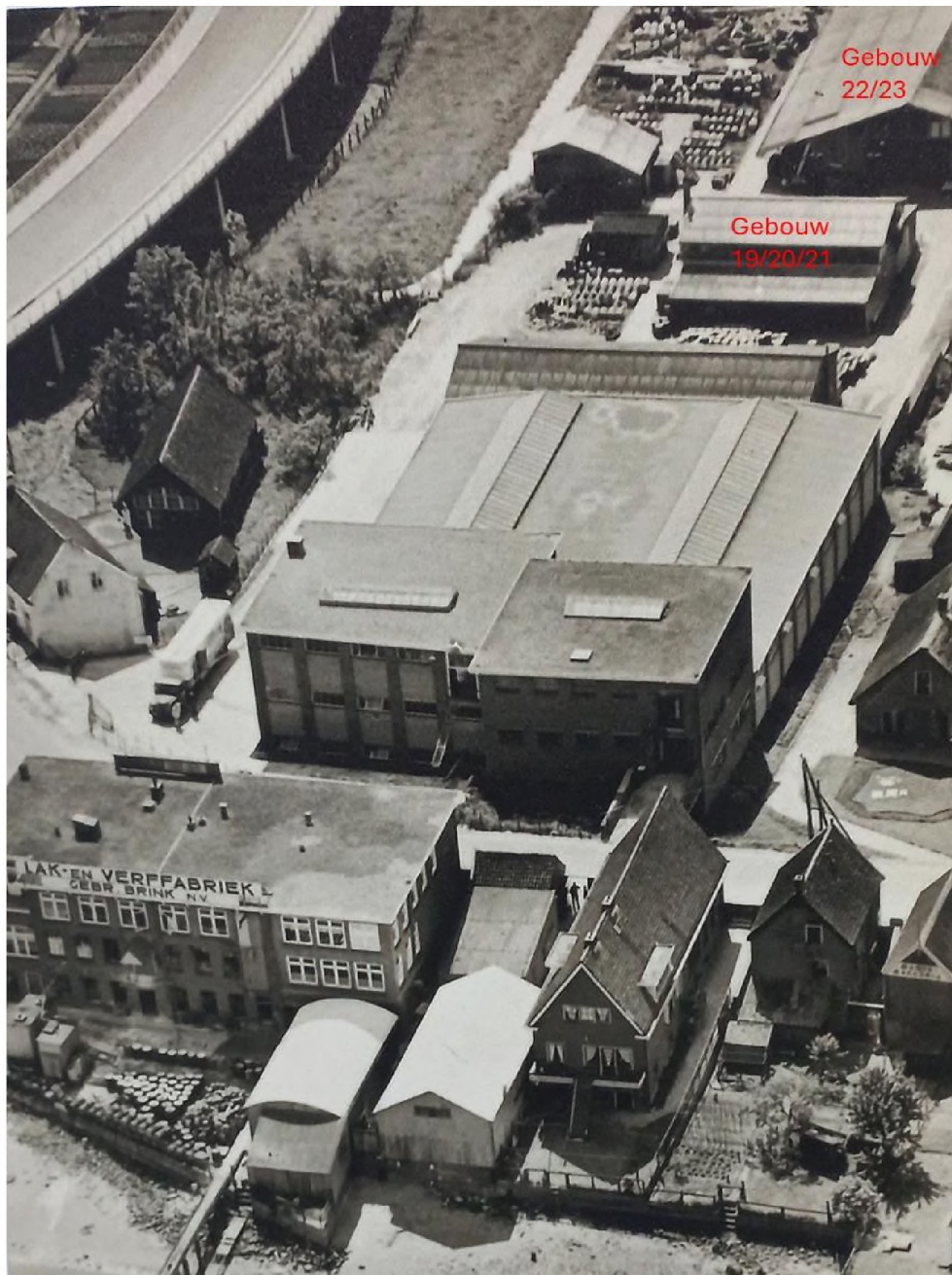
Figuur B1.4 Foto begin jaren 60 (bron: AkzoNobel). Aan de onderzijde van de foto is wederom het gebouw aan de lek direct naast de huidige veerpont te zien. Aan de overzijde van de weg (midden van de foto) staat het in 1986 gesloopte fabrieksgebouw dat moest wijken voor dijkverzwaring en buiten de huidige inrichting ligt. Aan de bovenzijde van de foto bevindt zich gebouw 19/20/21 en 22/23, welke de voormalige vatenopslag, de voormalige harssmelterij en de voormalige technische werkplaats betreft
