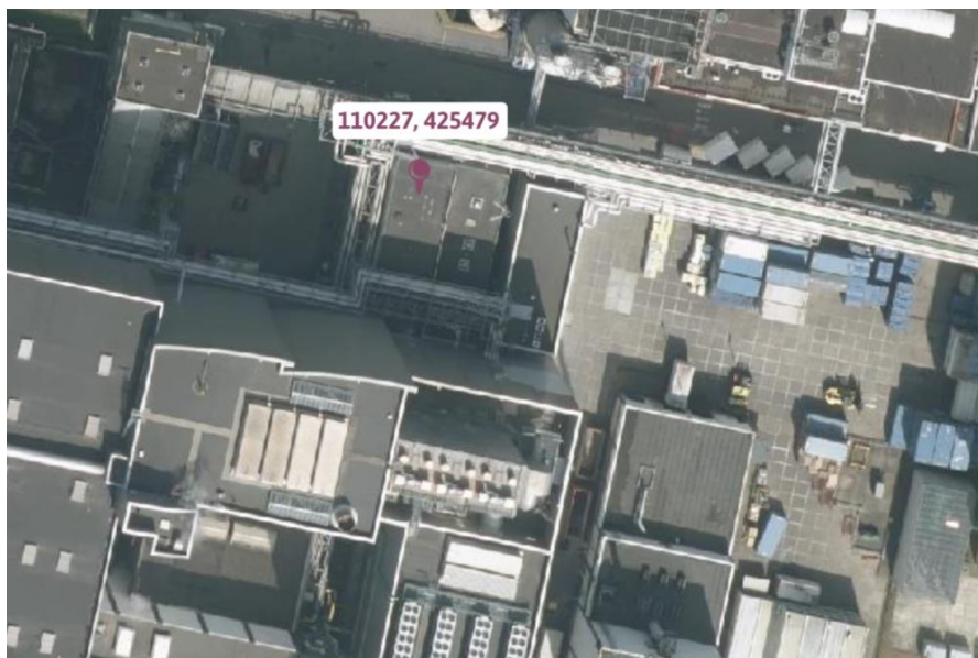
Figuur 1 Locatie tanks ijzerchloride en TMT
