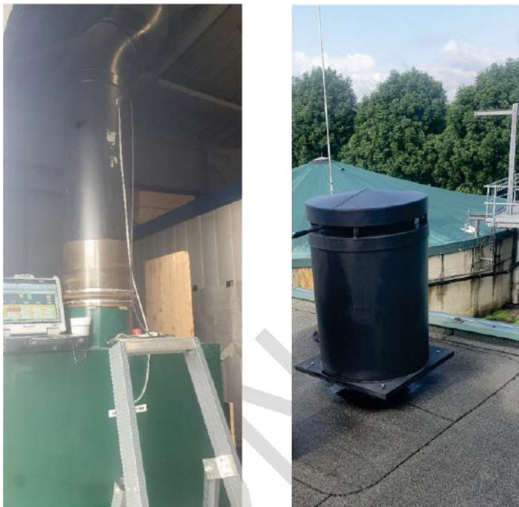
Figuur 4.2.1 Afbeelding van de afzuiging van het biofilter
