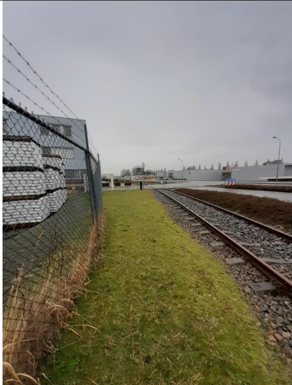
C.3. Meest noordelijke gedeelte spoorweg deellocatie C.
