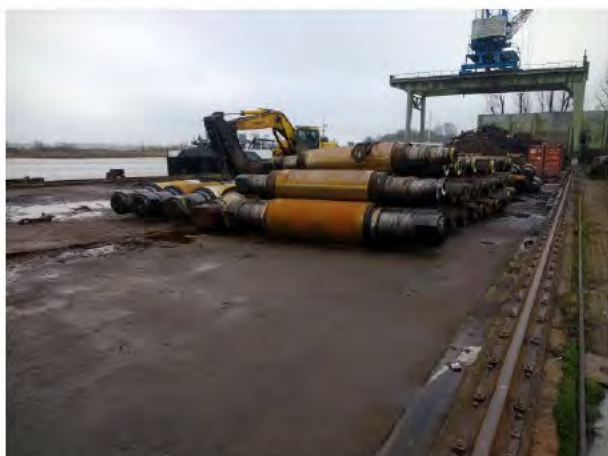
Foto 5: Overzicht vloestofdichte vloer
