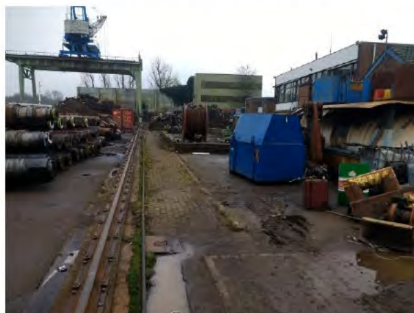
Foto 6: Overzicht ligging vloestofdichte vloer
