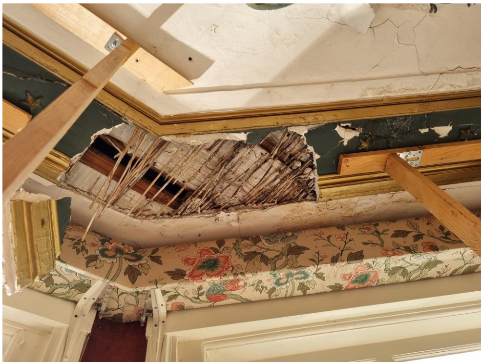
Detail plafondlijst bestaand.
