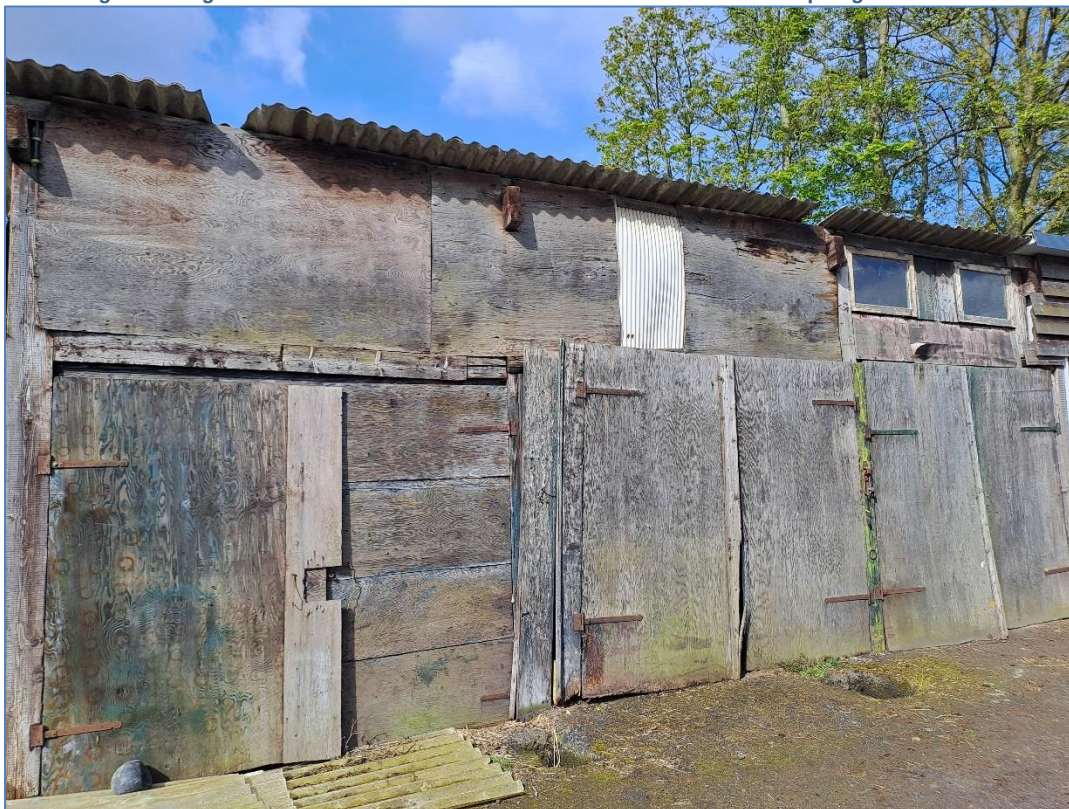
Afbeelding 12. Oostgevel van de te saneren schuur in het noordwesten van het plangebied.
