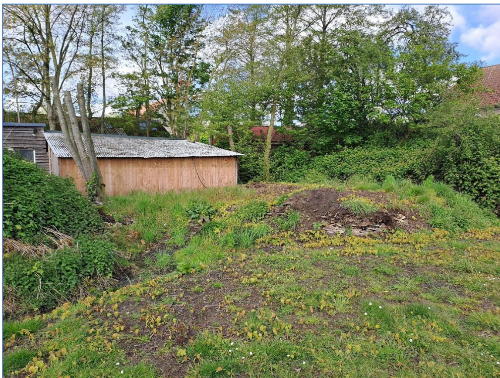
Afbeelding 3. Gerenoveerde gedeelte van de schuur in het noordwesten van het plangebied.
