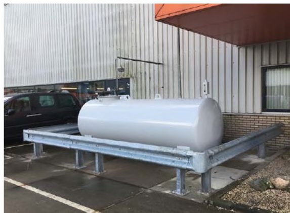
Vuile smeerolietank bij ingang werkplaats
