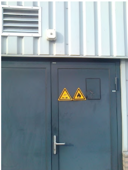
Witte waarschuwingslamp SOS opslag --> brandalarm SOS opslag
