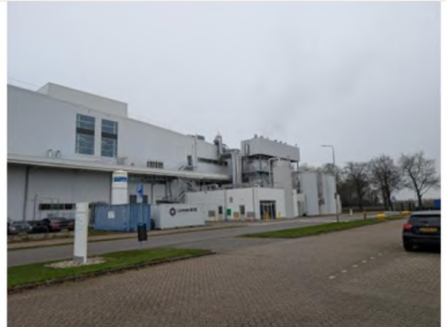
Noordoostelijke zijde van de projectlocatie.
