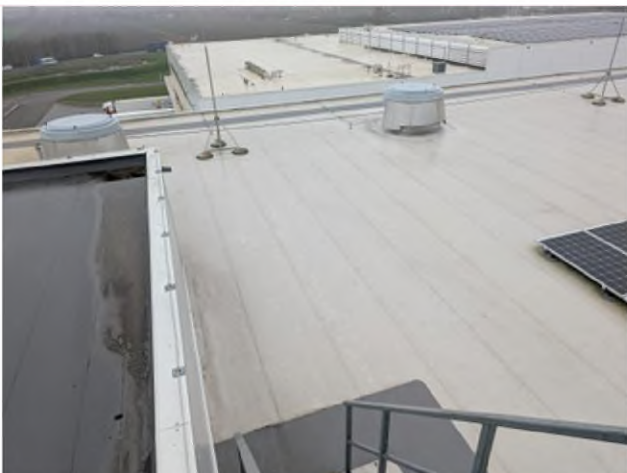
Dakoppervlak van projectlocatie.
