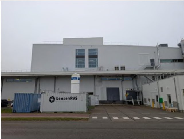
Noordoostelijke zijde van de projectlocatie.
