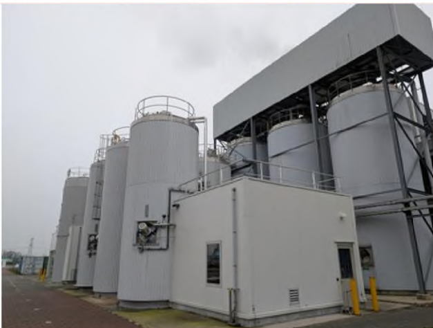
Oostelijke hoek van het projectterrein.
