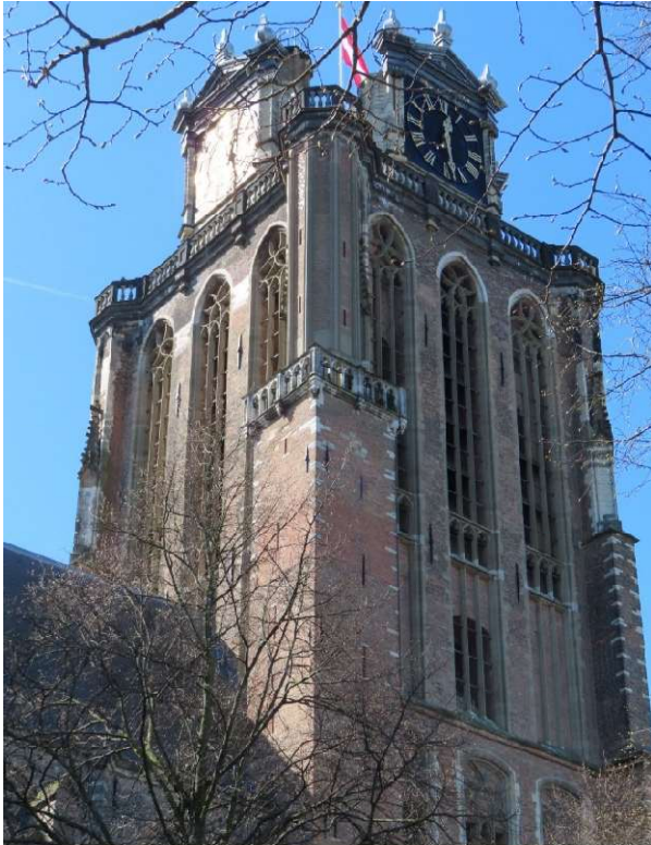
Oost- en noordgevel.
