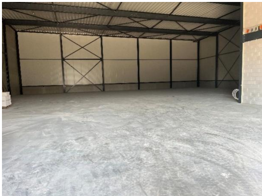
Biotisk bedrijfshal met glad afgevlinderde, aaneengesloten betonvloer
