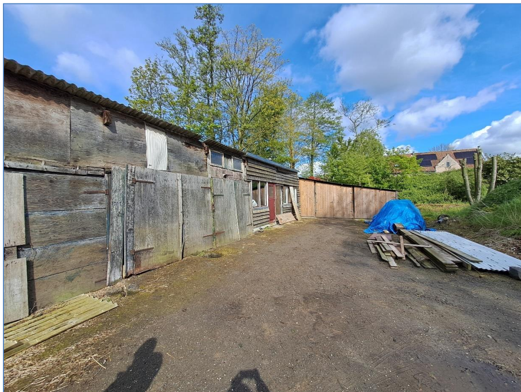
Afbeelding 11. Oostgevel van de te saneren schuur in het noordwesten van het plangebied.
