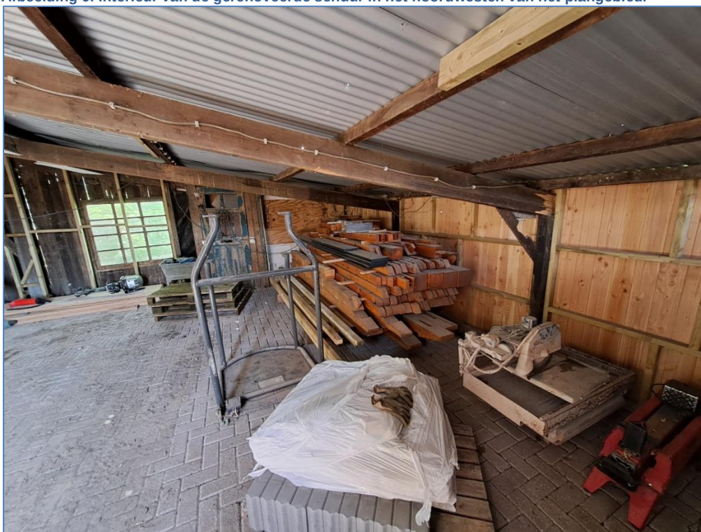
Afbeelding 10. Interieur van de gerenoveerde schuur in het noordwesten van het plangebied.
