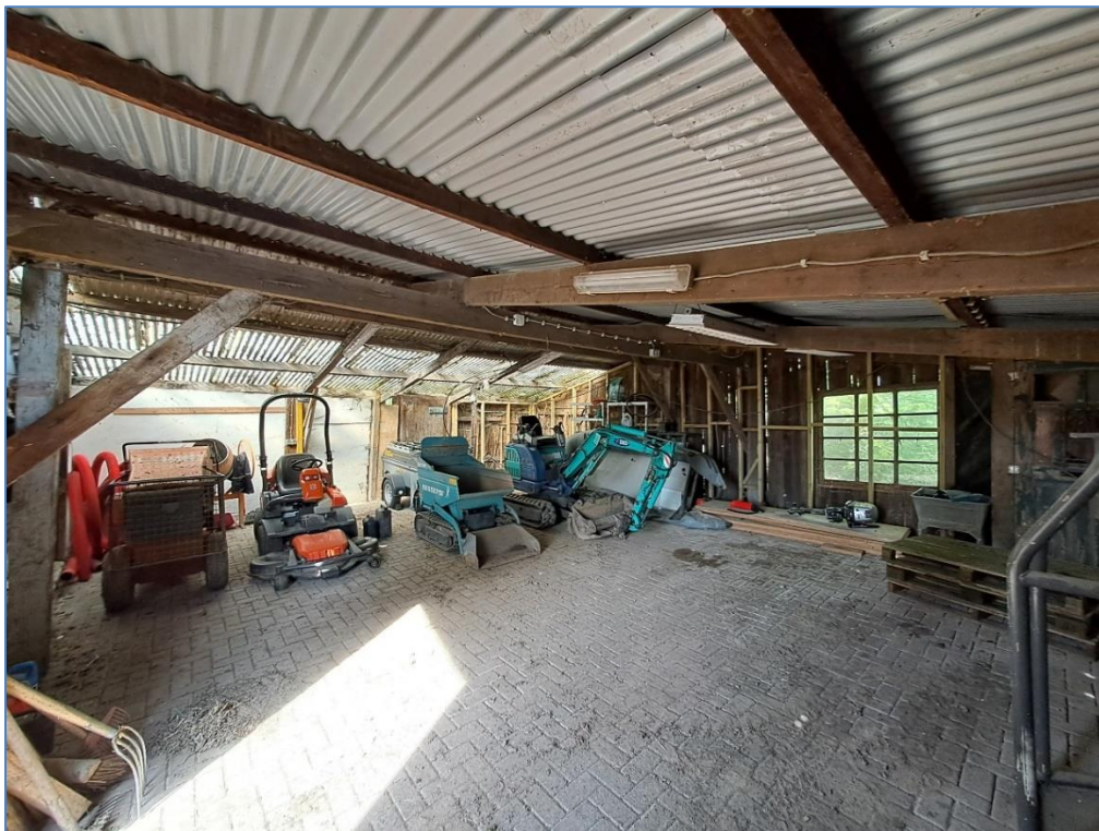
Afbeelding 9. Interieur van de gerenoveerde schuur in het noordwesten van het plangebied.
