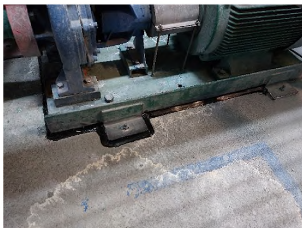
Fotonummer: 6 Omschrijving: Bij de wasplaats voor tanks is de onthechting van de voegvullingsmassa hersteld.
