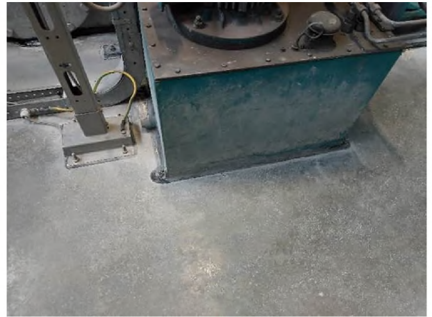
Fotonummer: 8 Omschrijving: Bij de wasplaats voor tanks is de onthechting van de voegvullingsmassa hersteld.
