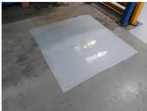
Fotonummer: 4 Omschrijving: Bij de Tapperij (gebouw 40) zijn de onthechting van de coating en de mechanische schades hierin hersteld.
