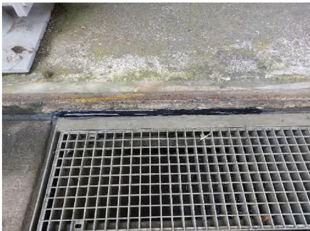
Fotonummer: 1 Omschrijving: Bij de losplaats oplosmiddelen is de onthechting van de voegvullingsmassa hersteld.
