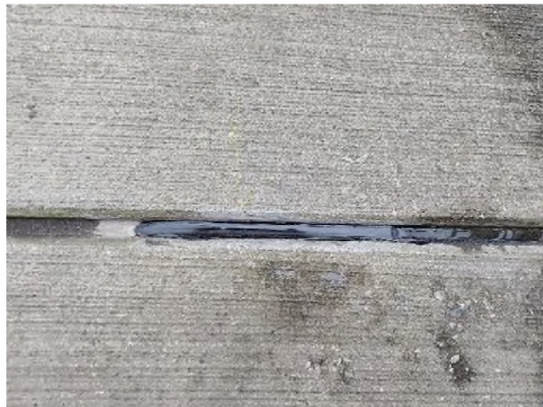
Fotonummer: 2 Omschrijving: Bij de losplaats oplosmiddelen is de onthechting van de voegvullingsmassa hersteld.
