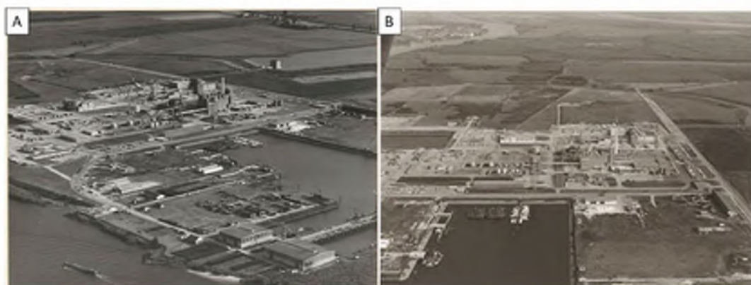
Figuur 3.5 A: Chemours 19-09-1963 door T. Slagboom. De rivier in de zuidwesthoek is de Beneden-Merwede, aan de bovenzijde van de foto is de Baanhoekweg zichtbaar 11 . B: Chemours-terrein in 1963, gefotografeerd vanuit het westen 12
