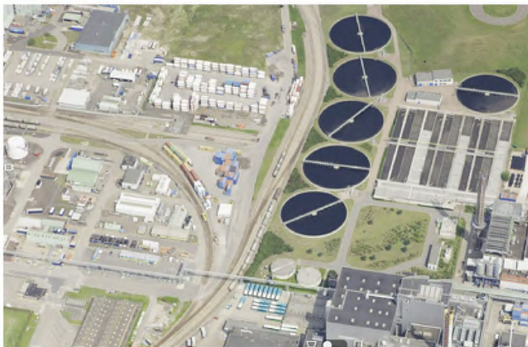
Figuur 3.4 In de periode 2000 - 2010 aangelegde bezinktanks ten oosten van het Chemours-terrein (bron: Streetsmart, datum foto 1 augustus 2015)
