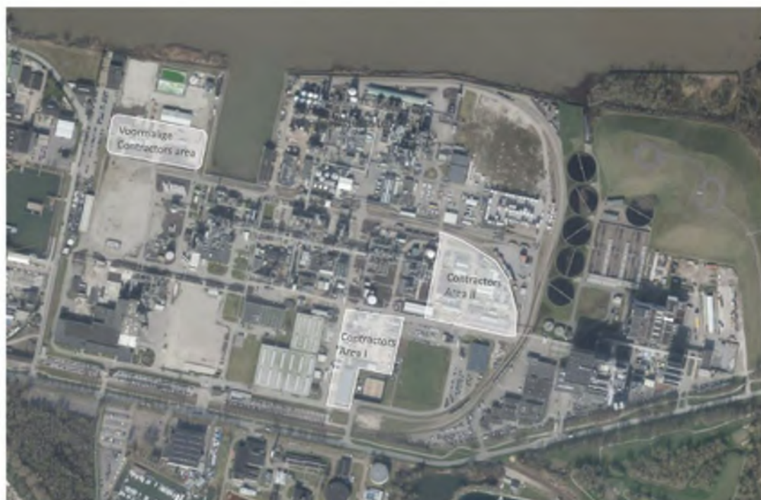
Figuur 5.4 Contractors Area (voormalig en nieuwe)
