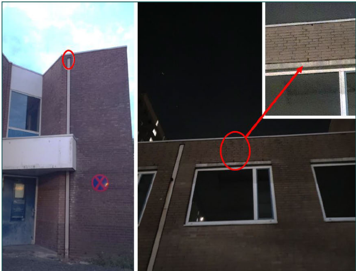
Figuur 3.2 Foto's van de door vleermuizen gebruikte invliegopeningen binnen de planlocatie. De linker foto weergeeft de invliegopening van de zomerverblijfsplaats (spleet naast goot). De rechter foto's weergeven de vermoedelijke opening die leidt tot de paarverblijfsplaats (stootvoeg).
