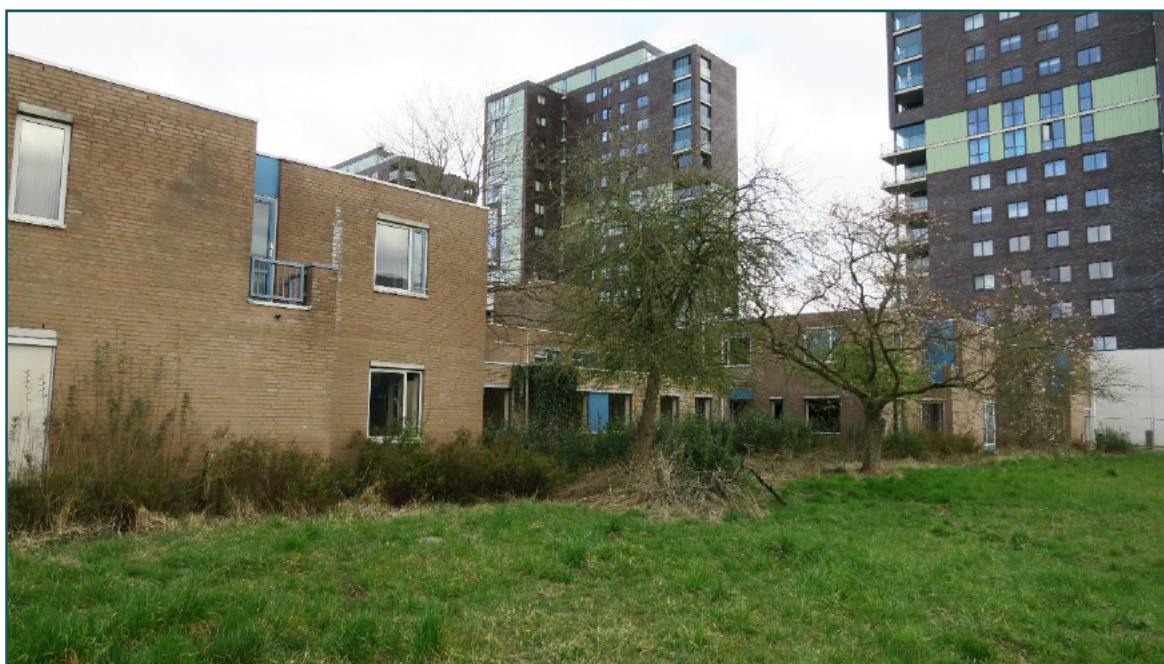
Figuur 2 De bebouwing bestaat uit 1-3 bouwlagen met gemetselde muren en platte, bitumen daken.
