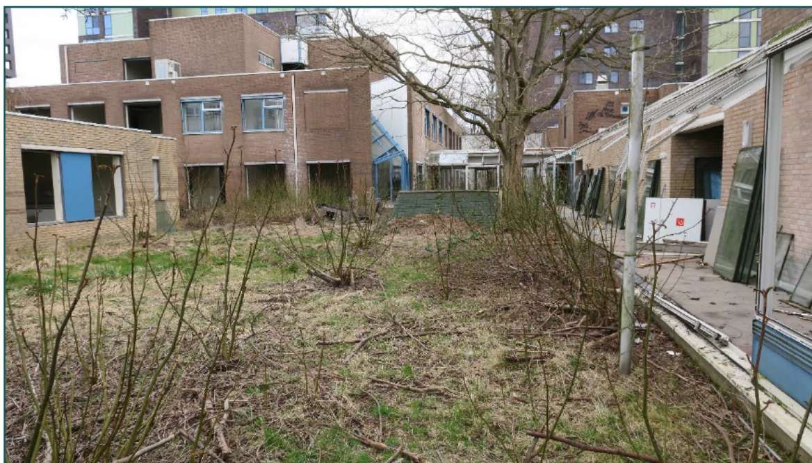
Figuur 3 Op de planlocatie is verwilderde begroeiing aanwezig.
