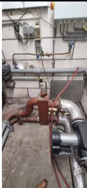
Foto 3: Diverse leidingen en appendages moeten nog worden geïsoleerd
