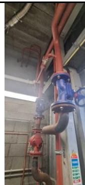
Foto 4: Diverse leidingen en appendages moeten nog worden geïsoleerd
