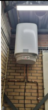
Foto 4: Diverse leidingen en appendages moeten nog worden geïsoleerd
