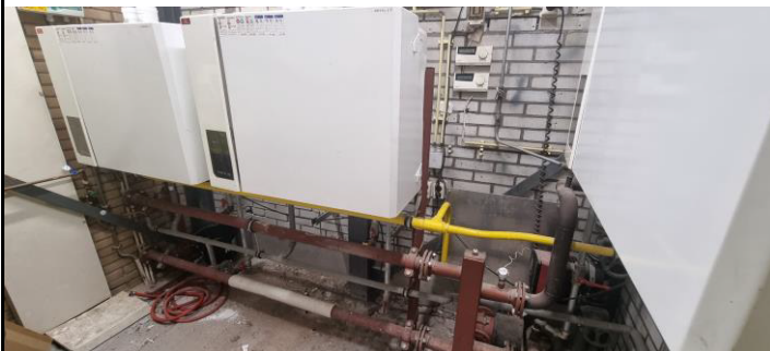
Foto 3: Diverse leidingen en appendages moeten nog worden geïsoleerd
