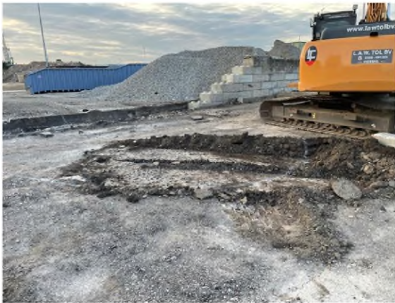
foto 1 Verwijderen asfalt en verharding
