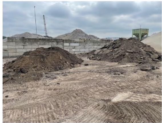
foto 2 Depots verharding en asfalt
