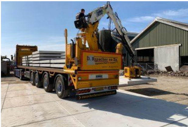
Figuur 4.4 Vervoer en plaatsing van stelconplaten. Bron: Russcher Staphorst B.V.
